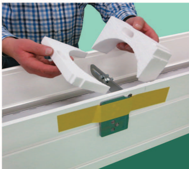
Dämmstücke für Statikkonsole in Rollladenkasten einsetzen
