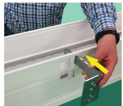
Konsolen Oberteil in Rolladenkasten einsetzen
