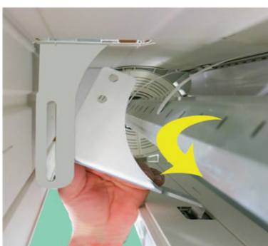
Konsole durch Basisbrett in Verstärkungseisen einhaken
