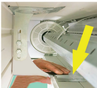
Statikkonsole auf Basisbrett mit beiliegendem Butylpad abdichten
