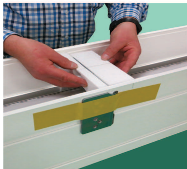
Dämmstücke für Statikkonsole in Rollladenkasten einsetzen
