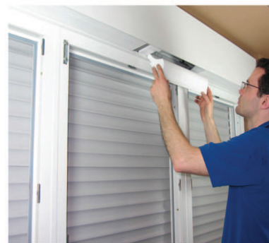
Dämmung einsetzen und Rollladenkasten schliessen
