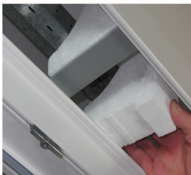
Dämmstücke in Statikkonsole einsetzen
