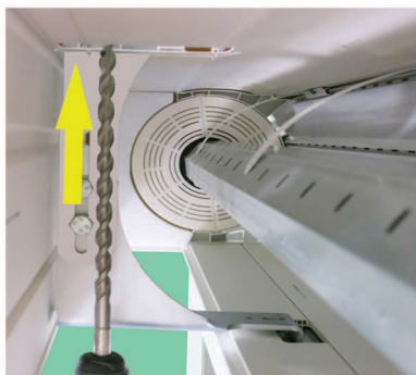
Löcher durch Konsole in Decke / Sturz bohren
