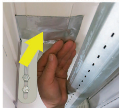
Durchgangslöcher in Deckelblende mit Butylpad verschließen
