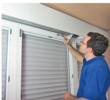
Statikkonsole durch Reviöffnung in Rollladenkasten einsetzen
