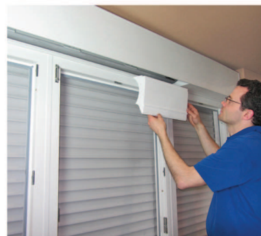
Dämmung und Dämmstücke aus Rollladenkasten entnehmen
