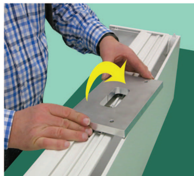
Frässhablone zur Seite schieben und entfernen
