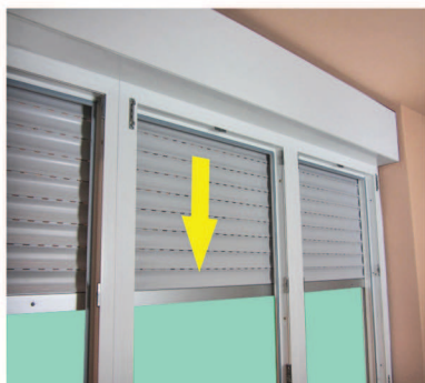
Rolladenpanzer an fertig montiertem Element schliessen
